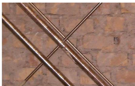
Figura 16. Modalità di rottura del pannello 7: distacco della malta dalla superficie dei mattoni.
