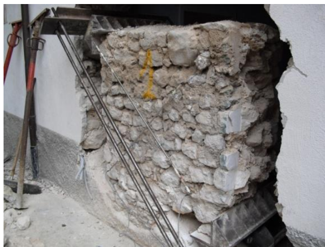
Figura 9. La prova di compressione diagonale presso l'edificio di Santa Maria della Misericordia.
