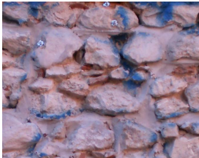
Figura 8. Particolare della tessitura muraria dei pannelli in muratura estratti da Palazzo Branconi-Farinosi.
