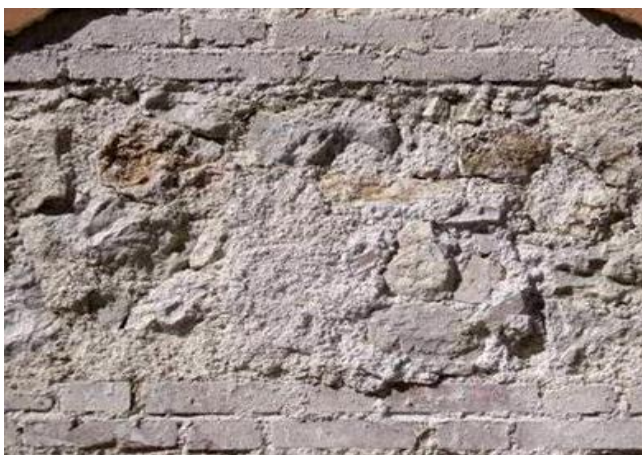
Figura 6. Particolare della tessitura muraria dell'edificio in Via XX Settembre.
