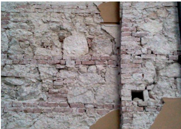
Figura 3. Particolare della tessitura muraria con listatura di mattoni degli edifici di Porta Napoli.
