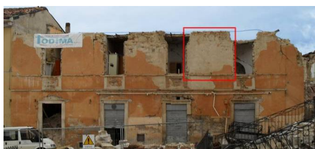
Figura 1. Vista del fabbricato sito in Piazza S. Pietro in Coppito destinato alla demolizione in cui sono stati individuati diversi pannelli oggetto di test in situ (in rosso è evidenziato quello oggetto di prova nel piano)
