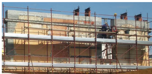
Figura 3. Vista generale del pannello di prova e dei setti di contrasto irrigiditi e rinforzati.
