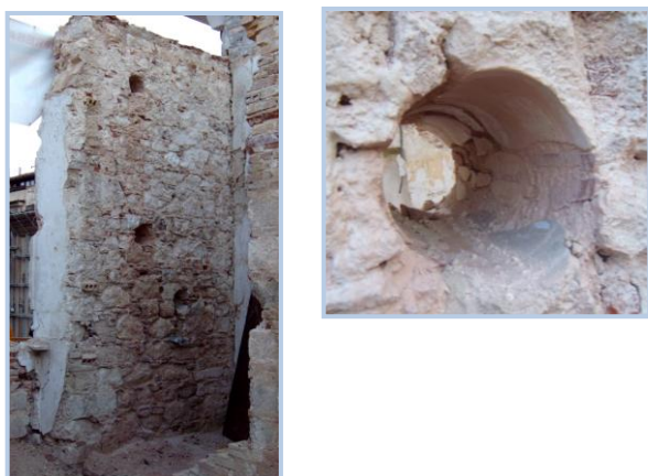
Figura 13. Foto perforazioni a mezzo carotatrice \varnothing 200. Da notare la pezzatura estremamente ridotta degli elementi rinvenuti lungo l'intera sezione.
