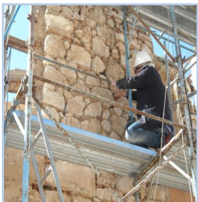
Figura 17: Preparazione del pannello rinforzato con la tecnica "ibrida"
